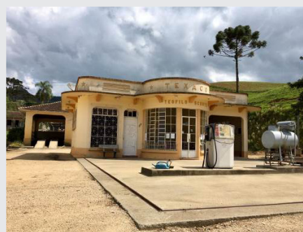
Figura 10 – Posto de gasolina nas margens do caminho, Rancho Queimado
